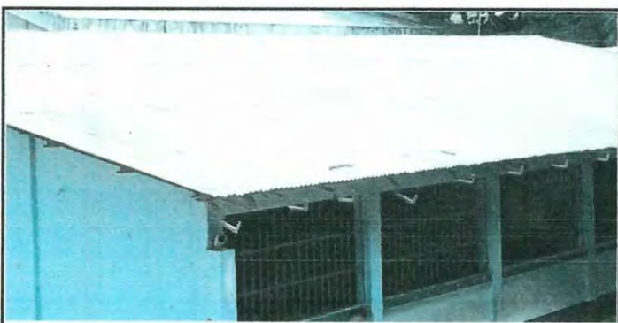
Foto 5: Se observa el deterioro de las láminas del modulo 3
