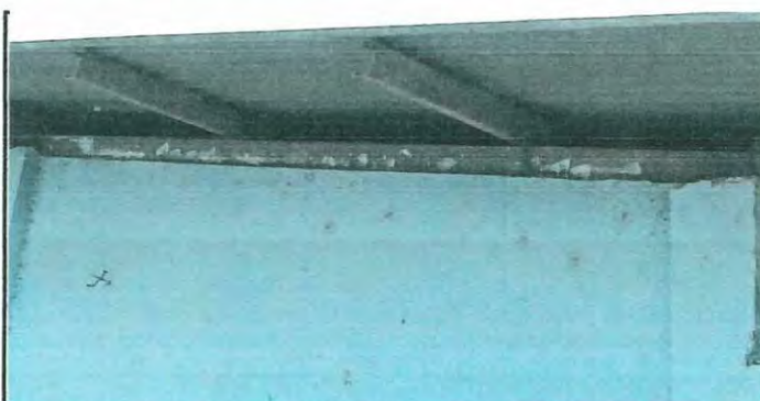
Foto 6: Se observa el deterioro de la estructura metálica
