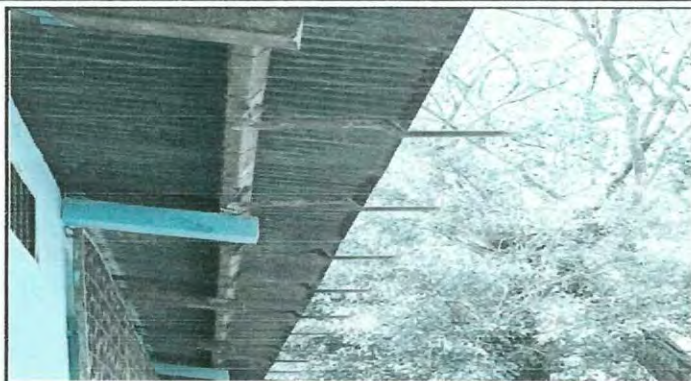
Foto 2: Se observa el deterioro de la estructura metálica de afuera
